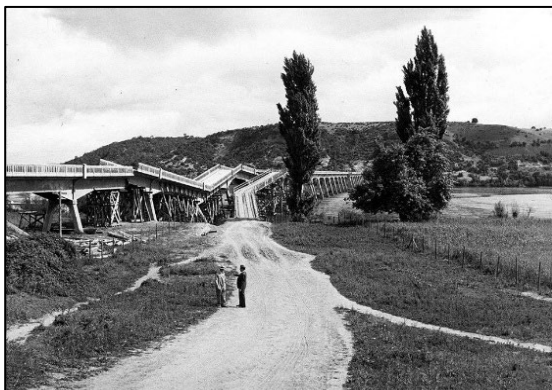
Figura 9: Puente de Ñipas, Terremoto 1939. (Biblioteca Nacional de Chile, n.d.-a)
