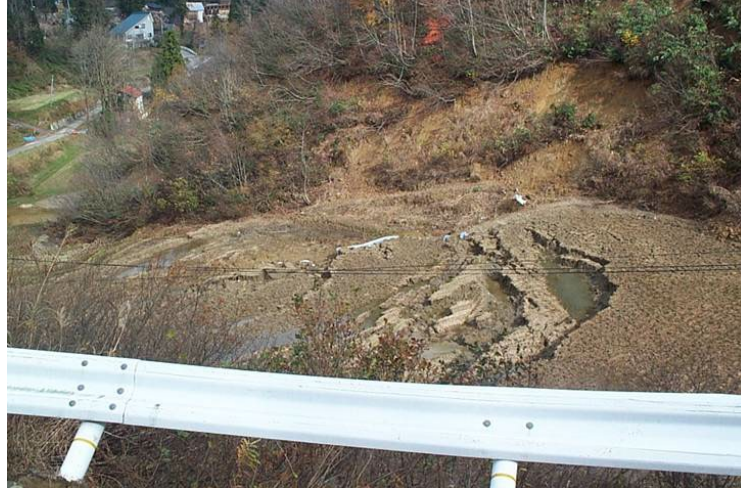
Figura 6: Deslizamiento de tierra, Yamakoshi 2004. (Ellen Rathje, n.d.)
