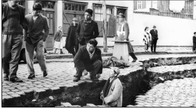
Figura 12: Grieta en la calle, Terremoto 1960. (Biblioteca Nacional de Chile, n.d.-a)
