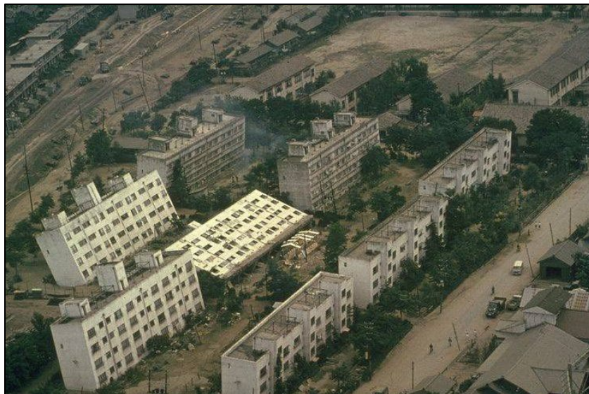
Figura 4: Edificios terremoto de Niigata 1964. (Washington.edu, n.d-a)
