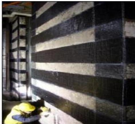
Figura 2.6 Refuerzo estructural de corte con tejidos de CFRP en muros. (Fuente: Catálogo Sika S.A.2016).
