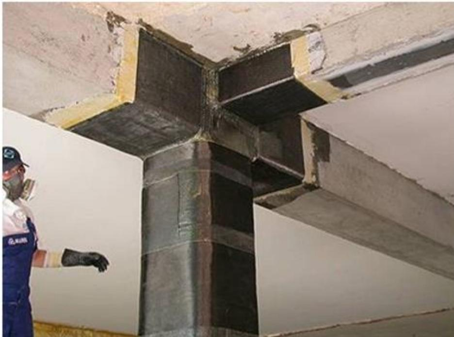
Figura 2.7 Refuerzo estructural de corte y confinamiento con tejidos de CFRP. (Fuente: Catálogo Sika S.A.2016).
