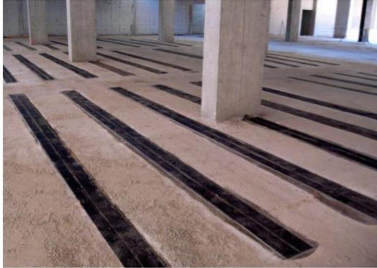
Figura 2.8. Refuerzo por flexión con pletinas de CFRP en losas. (Fuente: Catálogo Sika S.A.2016).
