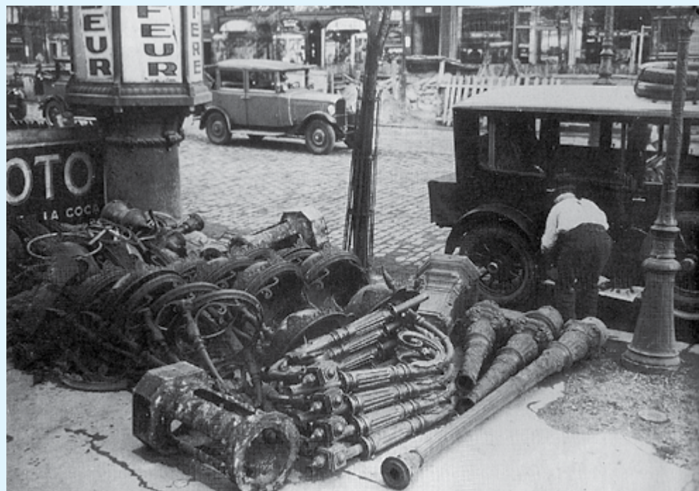
Como huesos de cadáveres, las viejas lámparas de gas ceden el paso a la luz eléctrica. Desaparición de las antiguas farolas de gas en París Fotografía anónima, c. 1880
