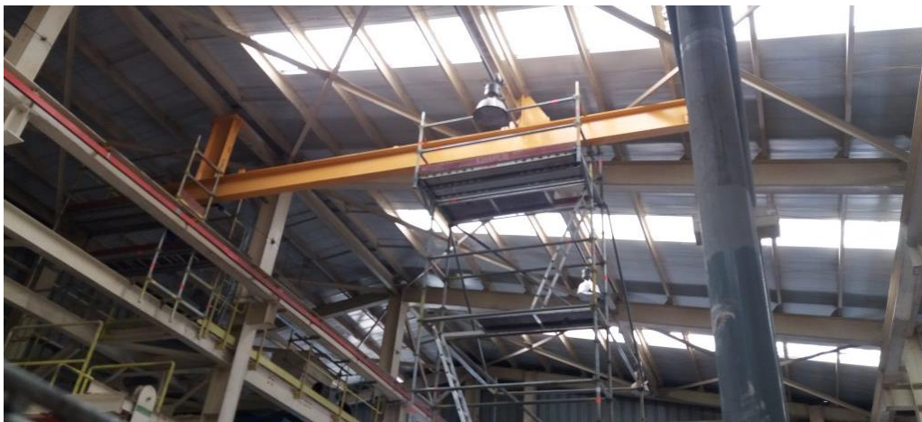
Figura 13: Instalación de Vigas para monorraíel
