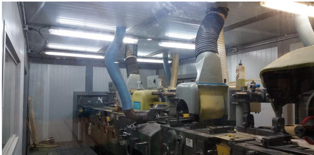
Figura 17: Aislación en Caños
