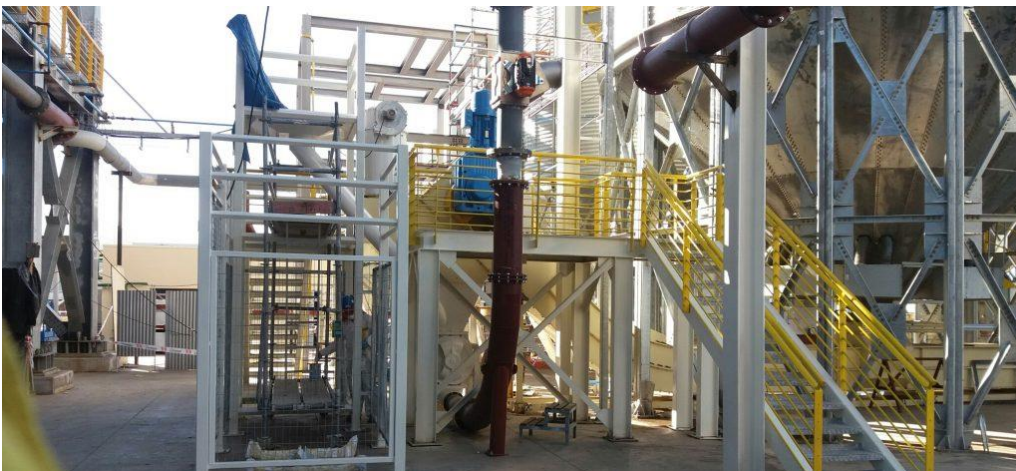
Figura 16: Montaje de cañerías.
