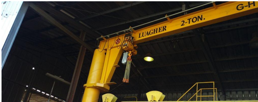
Figura 14: Instalación de Monorraíel terminada para Luagher
