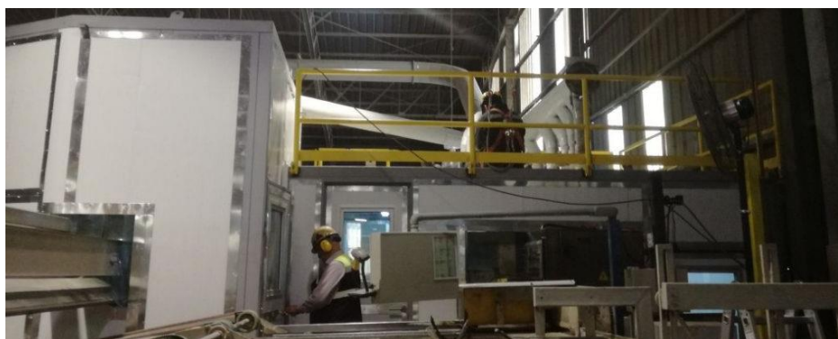
Figura 8: Mantención a caseta acústica.
