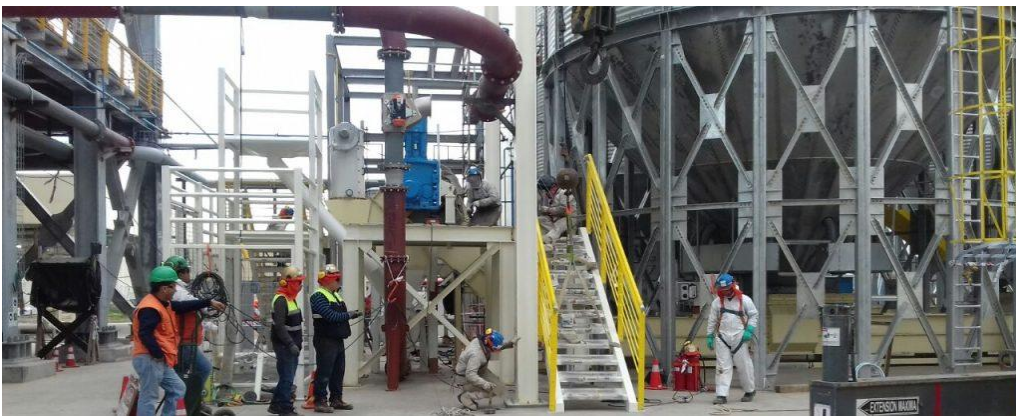
Figura 15: Montaje de estructuras
