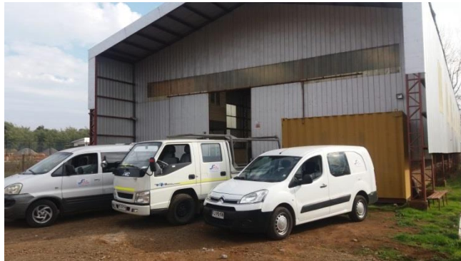
Figura 5: Oficina de instalaciones Yungay
