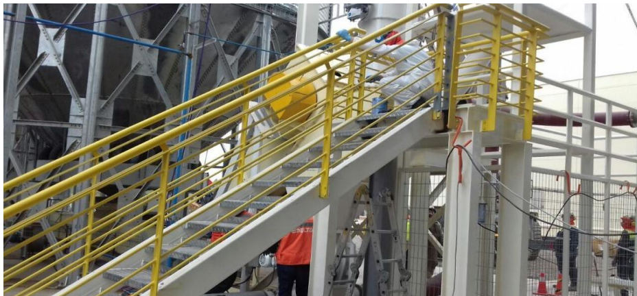
Figura 10: Mantención a estructuras de metal
